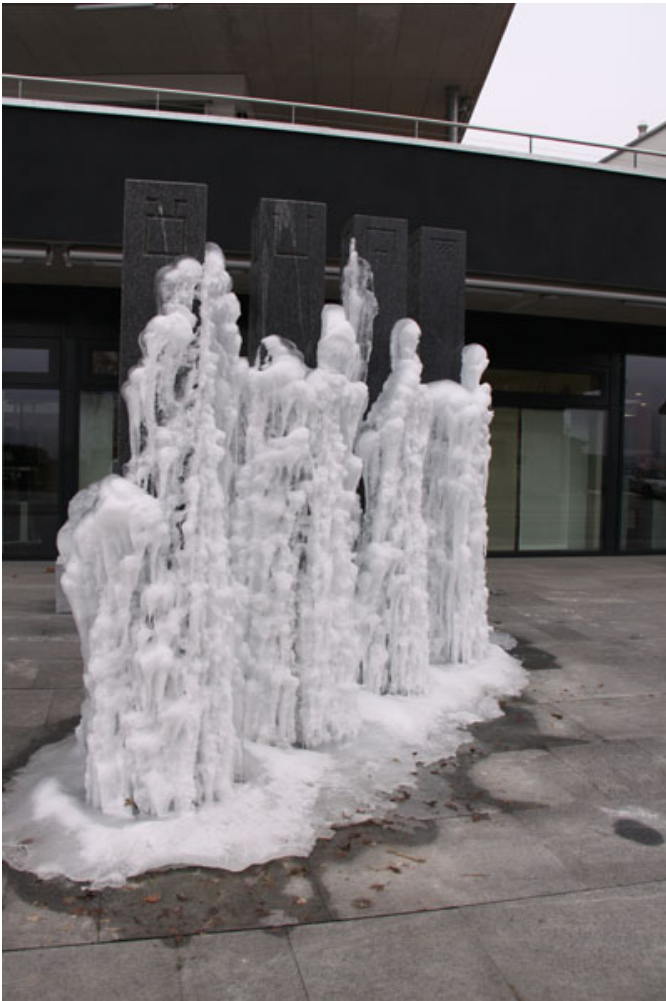
Die Anlage im Winter
